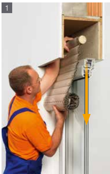
1 Alten Rollladen aus Kasten entfernen!
