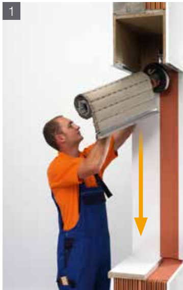
1 Alten Rollläden aus Kasten entfernen!
